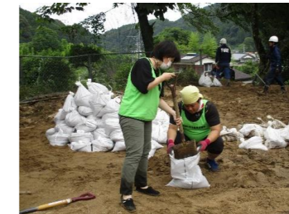
土嚢積み様子
